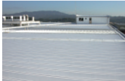
断熱塗装を施した豊田工場
