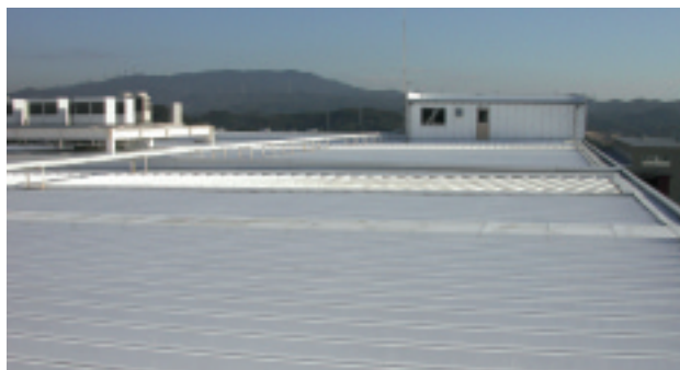
断熱塗装の屋根
